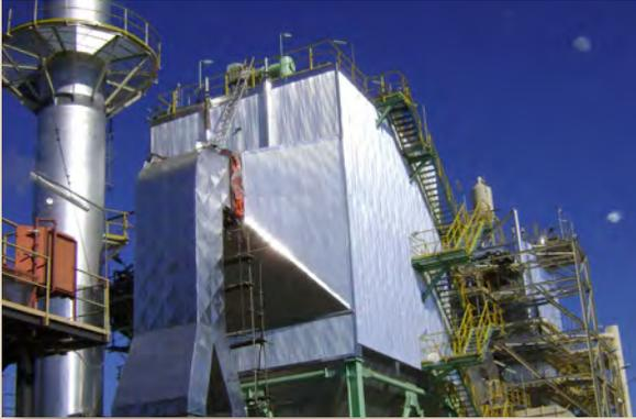
La planta de cogeneración de MASISA Ecoenergía proveerá de energía eléctrica para abastecimiento propio y eventualmente entregar al sistema interconectado central, además de vapor de baja presión para alimentar los secadores de madera.
